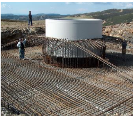
Fig. 20. Basamento in costruzione di una torre per aerogeneratore.
