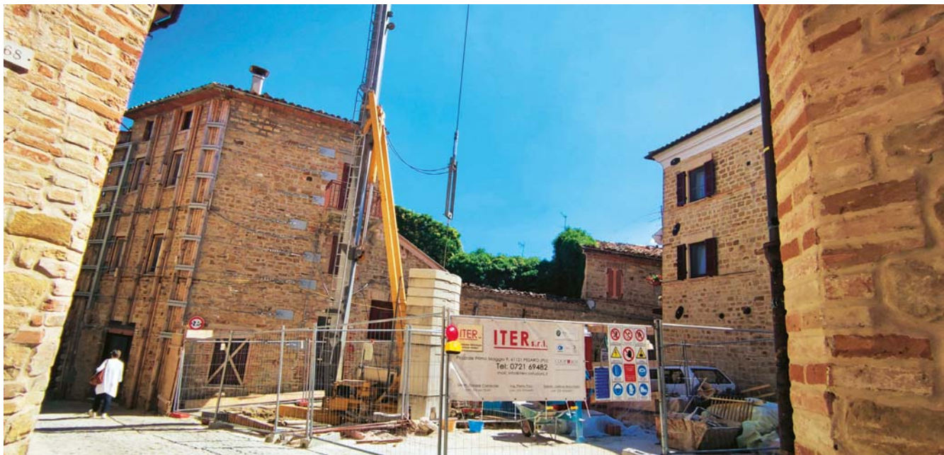
Sopra, lavori in corso a San Ginesio, Macerata
