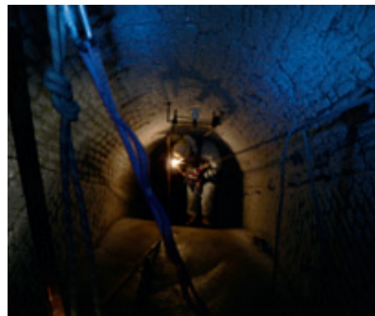
La rampa di discesa al livello 2.
