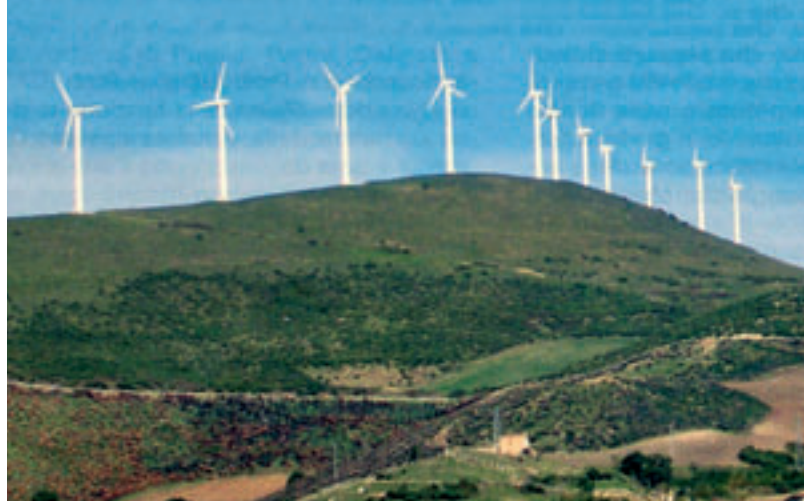
Centrale eolica di Accadia (Foggia).
