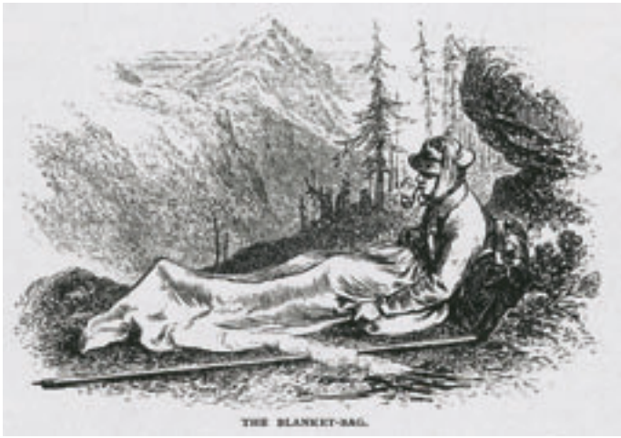
Bivacchi di ieri e di oggi: a sinistra la portaledge utilizzata dalla cordata italiana negli 11 giorni di permanenza sulla Torre del Paine (f. archiv. Fabio Leoni). Qui sopra: bivacco ai tempi di Edward Whymper, 1865 c.
