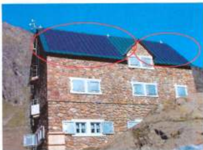
Qui accanto: Rifugio Migliorero (Piemonte) - impianto FV da 3,3 kW
