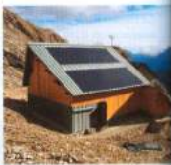
Rifugio Volpi (Veneto) - impianto FV da 2,3 kW - cogeneratore ad olio vegetale da 40 kW
