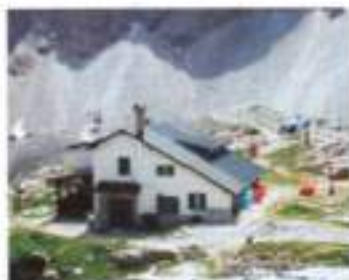
Rifugio Carducci (Veneto) - impianto FV da 1,9 kW - impianto miniidroelettrico da 1,5 kW - cogeneratore ad olio vegetale da 10 kW
