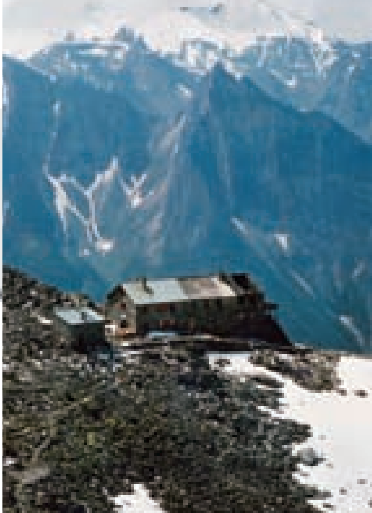
Qui sopra: Il Rifugio Europa prima dei lavori di ristrutturazione, visibili nella foto a fronte.
